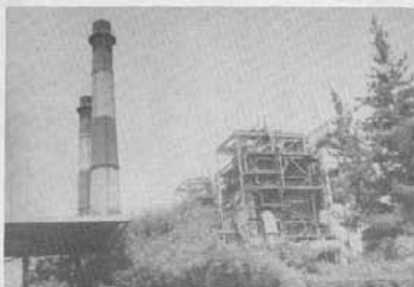
Un lugar característico de la comuna: su central termoeléctrica.
