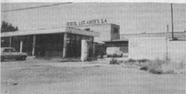
Una de las pocas industrias que quedan del otrora famoso "Cordón Industrial Panamericana Norte".
