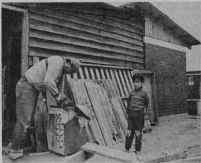
Abajo: un poblador construye su vivienda, adosada a la caseta.
