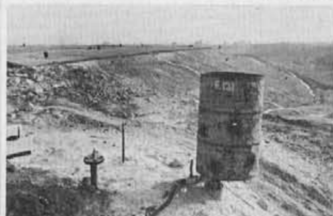
Quemadores de gas metano en el vertedero.
