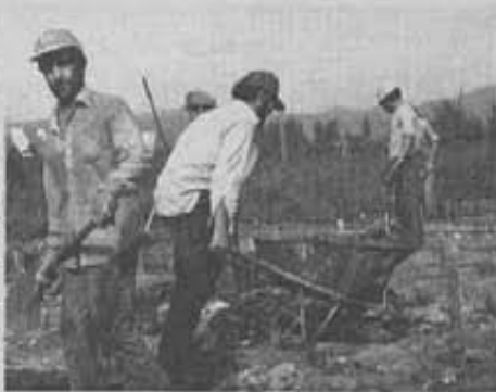
Los campesinos construyeron sus propias casas con la ayuda de profesionales de la Fundación CRATE del Obisepado de Talca.
