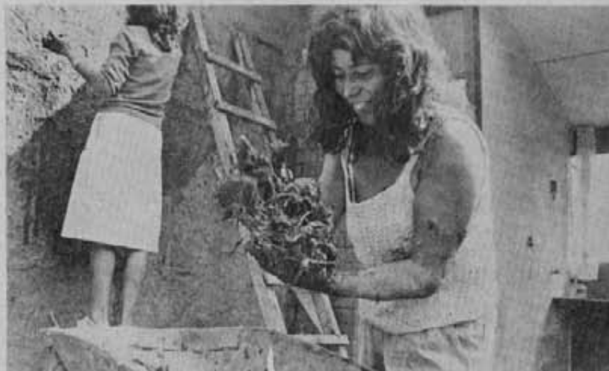
La mezcla de tierra, paja y agua forman el barro. Este se pudre y pasa a formar el abrigo del hogar.
