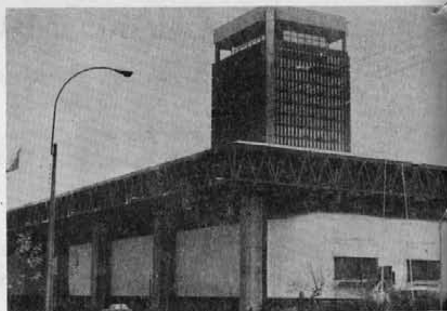
Edificio Diego Portales: ¿una etapa superada?
