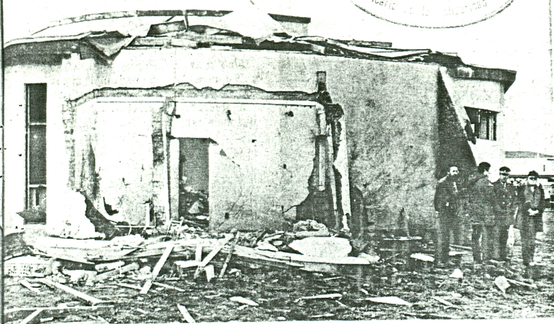
Así quedó la parroquia: "Parecía una demolición"
